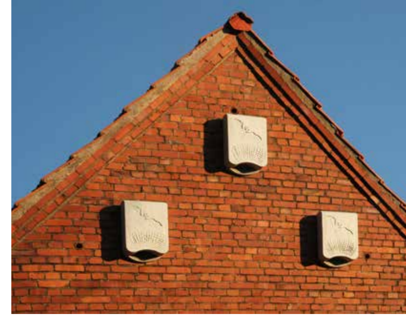
Fledermausspaltenkasten an einer Hauswand, Foto: B. Jedrzejek
