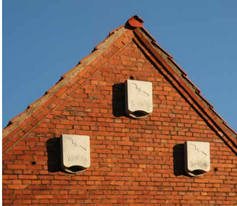
Fledermausspaltenkasten an einer Hauswand, Foto: B. Jedrzejek
