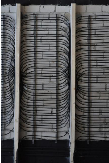
Abbildung 7-28: Schacht der Klimawand im Rohbau
