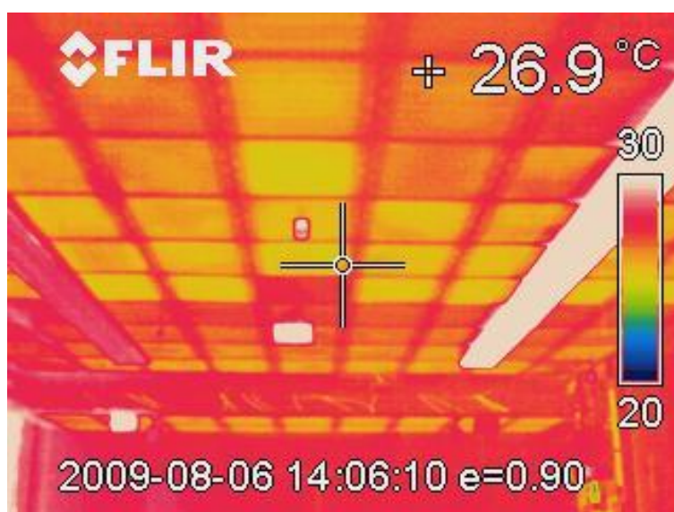
Abbildung 6-5: Thermografie-Aufnahme der Kühldecke in Raum 319 kurz nach dem Einschalten der Kühldecke
