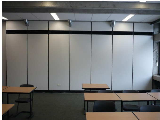
Abbildung 7-30: Geschlossene Klimawand (Sanierung im laufenden Betrieb)
