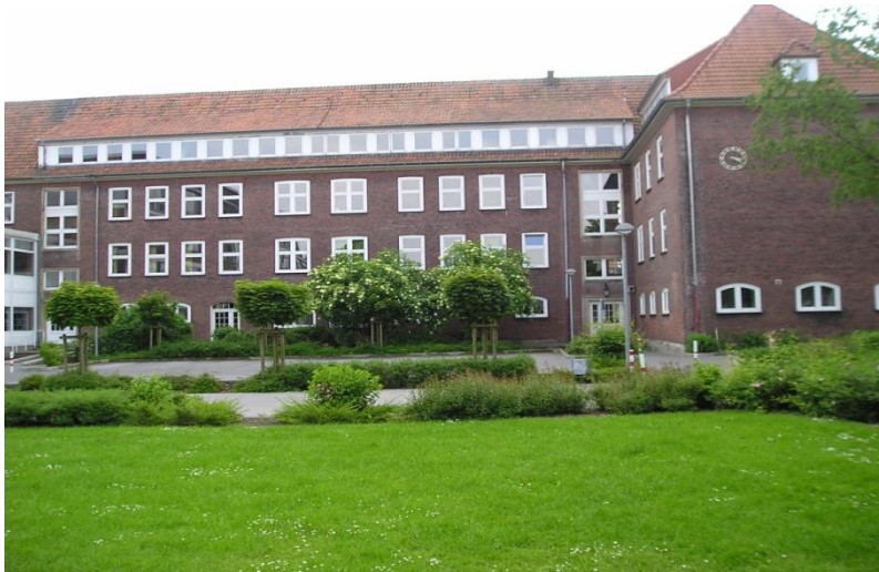
Abbildung 2-14: Haus III der Wirtschaftsschule Steinfurt (2007), Baujahr 1938
