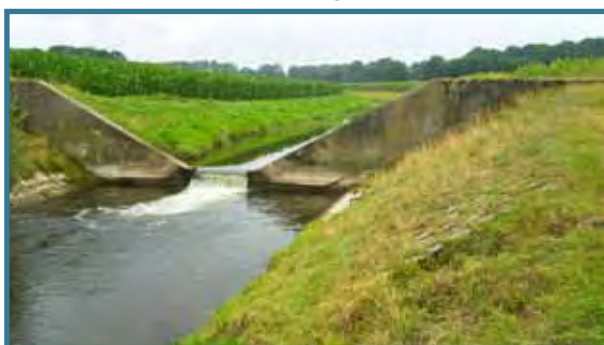
Einschnürungsbauwerk bei normaler Wasserführung
