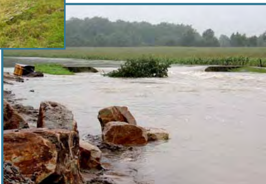
Einschnürungsbauwerk beim Hochwasser
