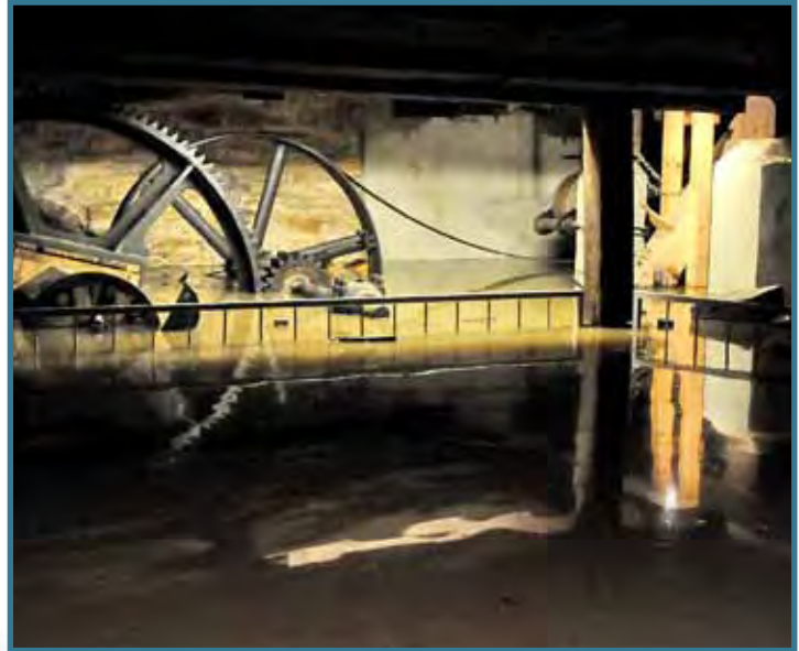
Aufnahme von den Kellerräumen im Restaurant Schlossmühle
