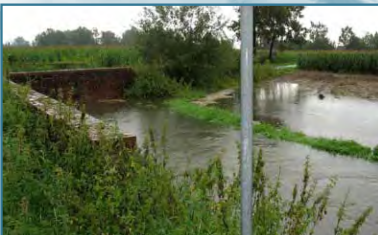
Kuhrietsbach im Bereich Alt-Metelener Weg (Aufnahmen sind entstanden vor dem Hoch- wasserscheitel)
