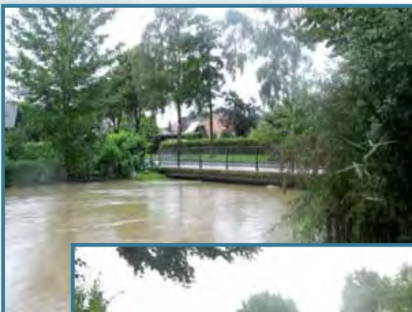
Ansicht Brücke Nieporter Esch, oberhalb
