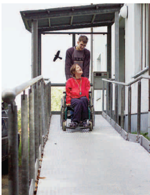
Überdacht, sicher und barrierefrei: Ein optimaler Hauseingang wird diesen Vorgaben gerecht.
