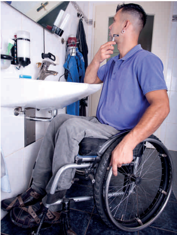
Ausreichend Freiraum unter dem Waschbecken bedeutet zugleich mehr Beinfreiheit. Hier ist Platz für einen Rollstuhl oder eine Sitzgelegenheit.
