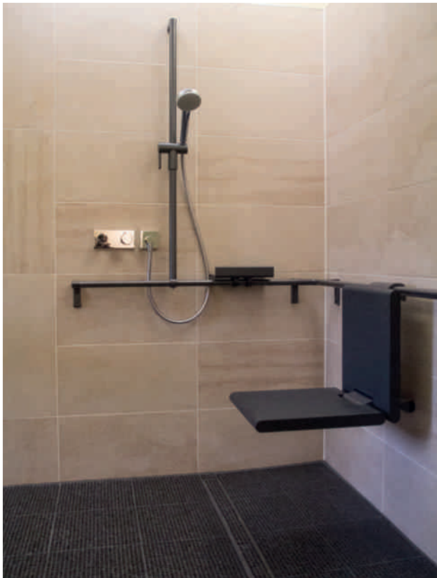
Bequem zu reinigen, rutschsicher, mit Haltegriffen und einem im Bedarfsfall klappbaren Duschhocker: Dieses Bad ist barrierefrei.
