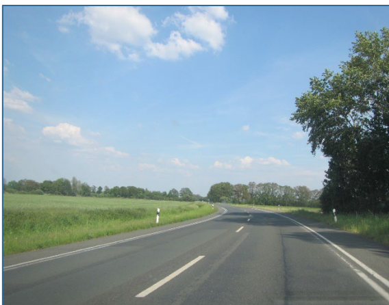
Abb. 13: Mehrzweckfahrstreifen an der L583 (Neuenkirchen)
