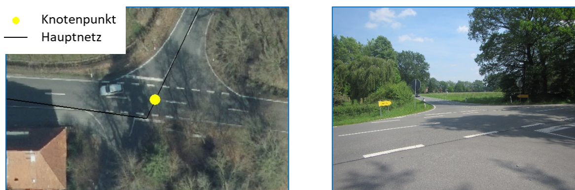
Abb. 19: Vorfahrtgeregelter Knotenpunkt (Kattenvenner Str./Glandorfer Damm bei Lienen)
