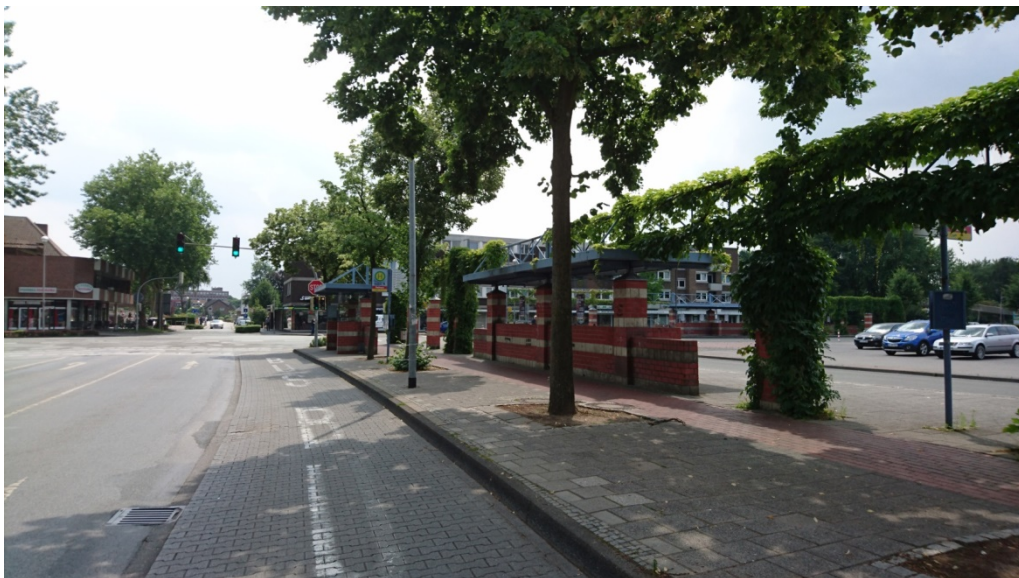
■ Abbildung 13: An Haltestellen mit Natur- bzw. Betonsteinpflaster kann die spaltfreie Anfahrbarkeit der Haltestellenkante durch Spurrillenbildung mittel- bis langfristig behindert werden (Beispiel: Haltestelle Greven Rathaus/ ZOB)
