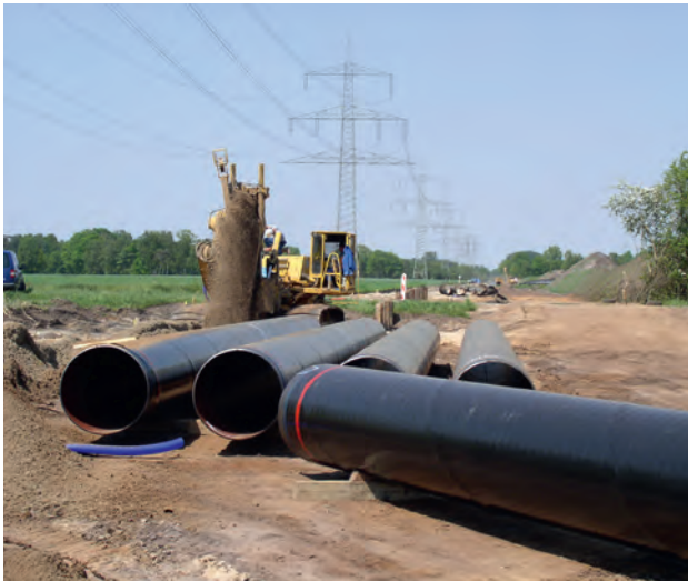
Ferngasleitungsbau in der Gemarkung Steinfurt
