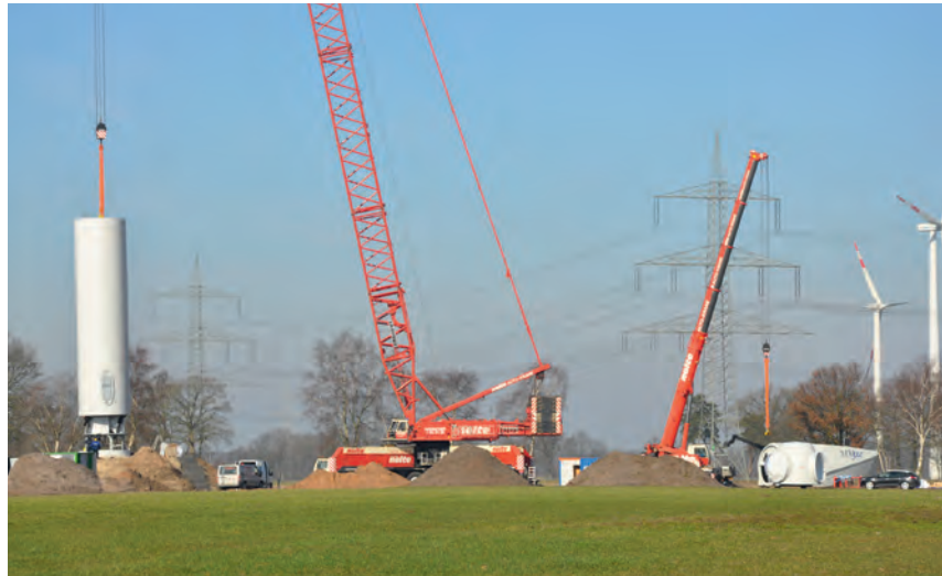
Bau einer Windkraftanlage in Hollich
