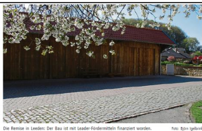
Die Remise in Leeden: Der Bau ist mit Leader-Fördermitteln finanziert worden.
