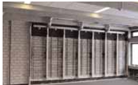
Abb. 8-3: Klimawand im Rohbau
