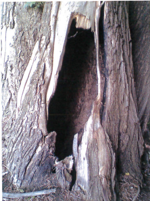
Abb. 2 Brandspuren innerhalb der Hohlräume
