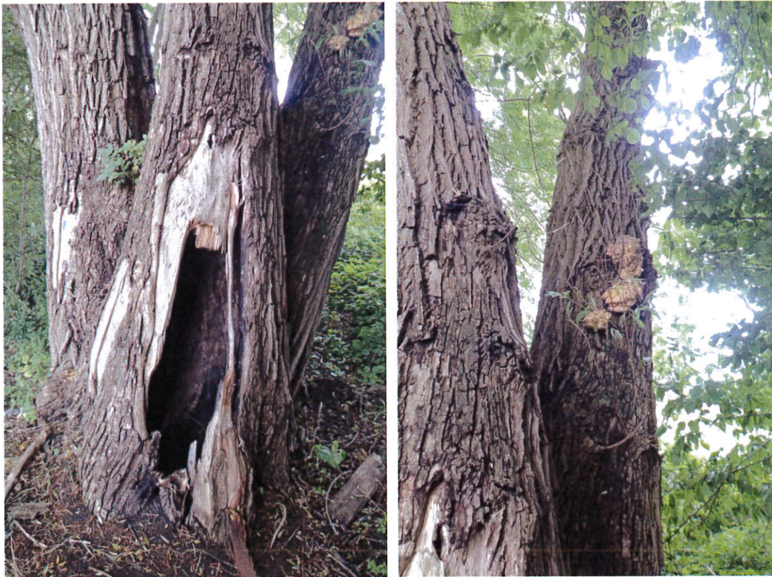
Abbildungen 2 und 3: Stark geschädigte alte Weide im Trassenverlauf der „Variante Landwirtschaft / WLV“.
