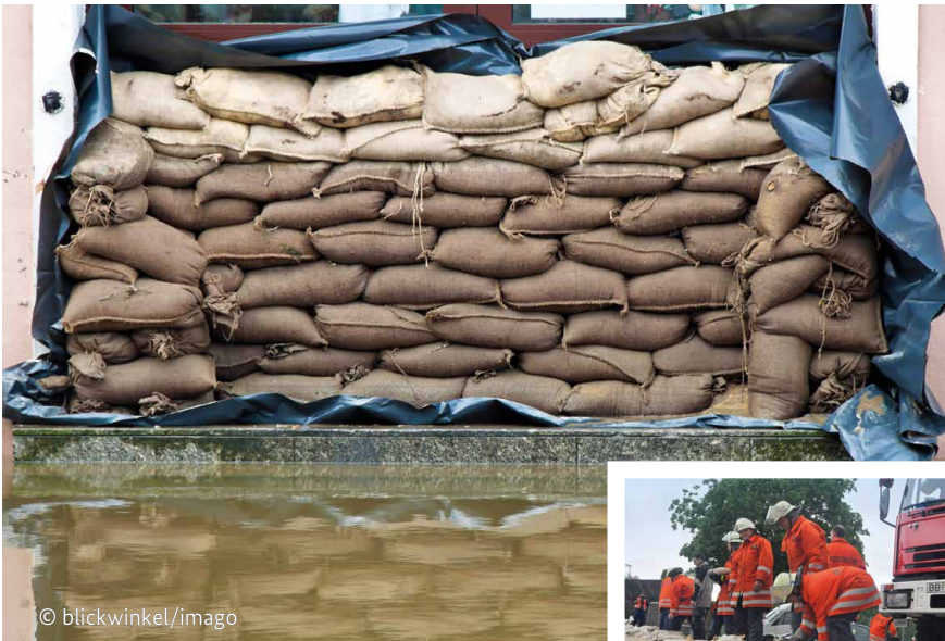
Schutzwälle aus Sandsäcken
