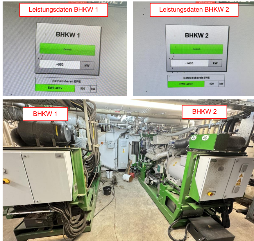
Abbildung 3: Leistungsdaten der BHKW während der Messung (oben) und Position der BHKW im Gebäude (unten)
