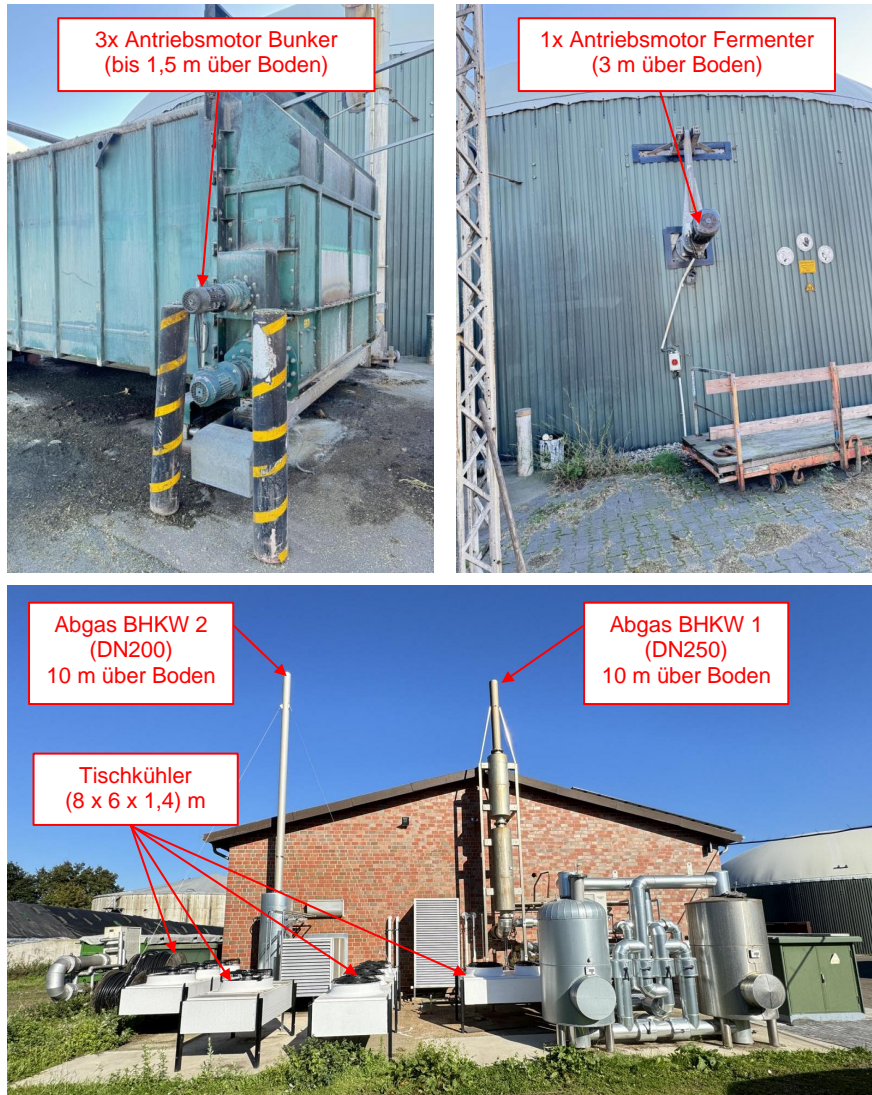
Abbildung 2: Lage der Antriebsmotoren im Bereich des Fermenters (oben) und BHKW-Gebäude mit Tischkühlern und Abgasrohren (unten)
