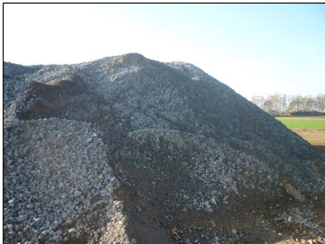
Abbildung 12: Überreste eines entfernten und zerkleinerten WEA-Fundamentes (enveco GmbH).
