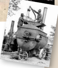
Rechts: Befüllung des Bitumenerhitzers 1930 an der L 501 Rheiner Straße. Bildarchiv: Stadtmuseum Ibbenbüren
