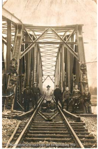
Die Eisenbahnbrücke kurz nach der Fertigstellung 1913
