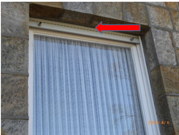
Foto 12: Wohnhaus Kümperweg 45, ca. Bau-km 1+718, Fenster mit Rollladen, Aufnahme 06.04.2018
