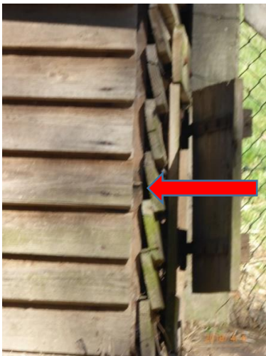
Foto 21: Holzschuppen/Schafstall im Grünland am Kümperweg, Nord, ca. Bau-km 1+926, Wand mit schräg überlappenden Bretter, Aufnahme 06.04.2018
