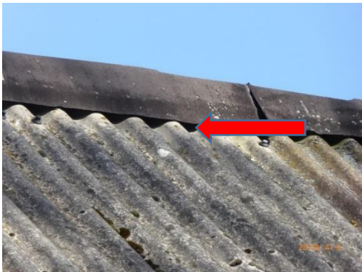
Foto 20: Holzschuppen/Schafstall im Grünland am Kümperweg, Nord, ca. Bau-km 1+926, Dachfirst mit gewellten Eternitplatten, Aufnahme 06.04.2018
