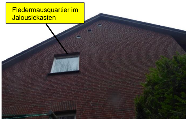
Abb. 2: Foto vom Giebel des Hauses Guntherstraße 19
