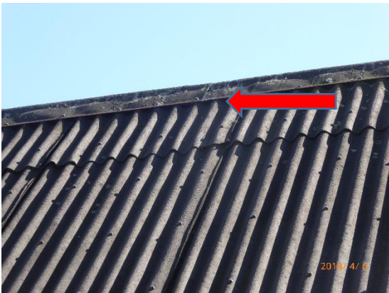
Foto 23: Wohnbaugrundstück Theodorstraße 45, Nebengebäude, ca. Bau-km 1+933, Dachfirst mit gewellten Eternitplatten, Aufnahme 06.04.2018
