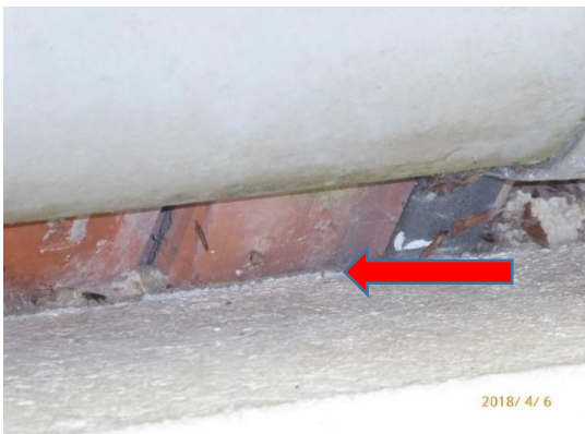
Foto 17: Wohnbaugrundstück Kümperweg 45, Nebengebäude, ca. Bau-km 1+700, Quartierpotential zwischen Gebäudewand, Dachpfannen und Regenrinne, Aufnahme 06.04.2018
