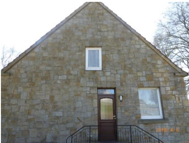
Foto 11: Wohnhaus Kümperweg 45, ca. Bau-km 1+718, Aufnahme 06.04.2018
