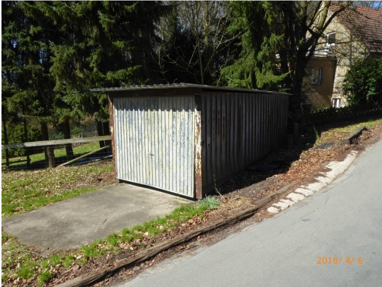
Foto 18: Wohnbaugrundstück Kümperweg 45, Garage, ca. Bau-km 1+696, Aufnahme 06.04.2018
