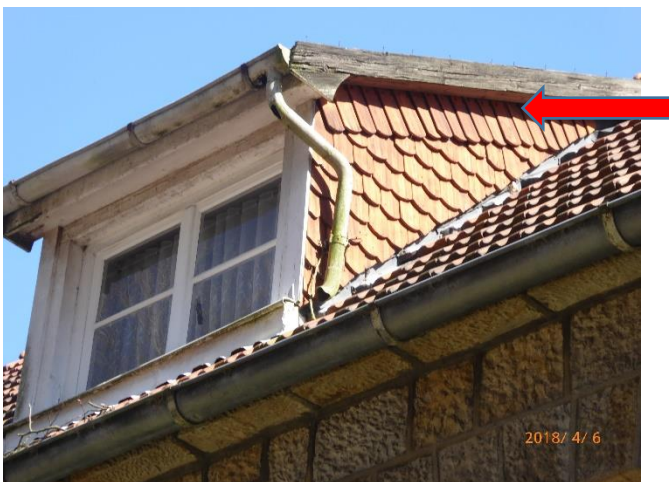
Foto 14: Wohnhaus Kümperweg 45, ca. Bau-km 1+718, Dachgaube mit Schindeln, Aufnahme 06.04.2018
