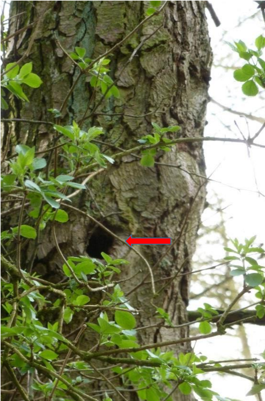
Foto 7: Schwarzerle bei Bau-km 1+989, Aufnahme 12.04.2016
